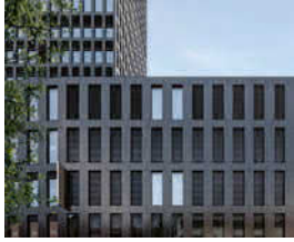
Beim Grosspeter Tower in Basel greifen die beiden Volumen Sockel und Turm ineinander. Dünnschicht-Solarmodule sind in sämtliche Fassadenelemente integriert. Die Grösse der Fassadenöffnung ist entsprechend der Nutzung angepasst. Coverfoto von Philipp Funke .
