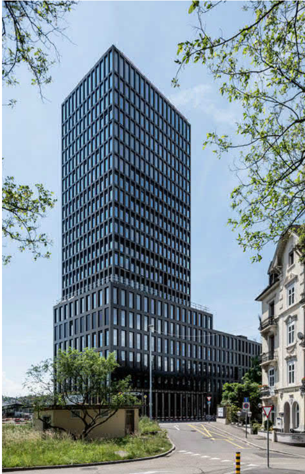
Die Pfosten und Riegel der Fassade des Grosspeter Towers lösen sich mit steigender Gebäudehöhe zugunsten grösserer Fassadenöffnungen auf. Das Tragwerk hinter der Fassade und die Solarmodule in den Fassadenpaneelen entsprechen dieser abgestuften Abmessung. Das ergibt trotz technisierter Fassadenelemente ein stimmiges Gesamtbild .
